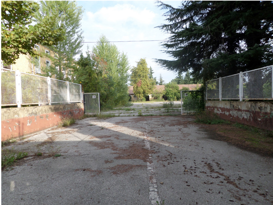
Figura 1. Estat d'abandó de la caserna Salsa a Treviso.
