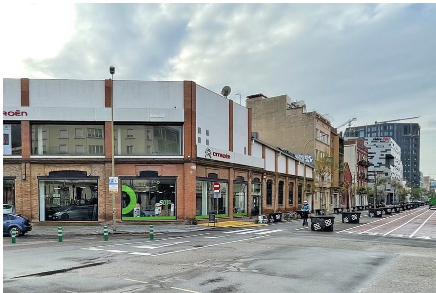
Figura 6. Vistes actuals de l'edificació al sector del Poblenou
