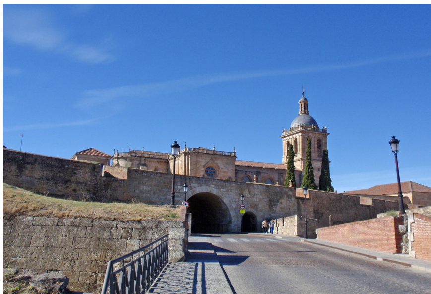
Figura 1. Detalle de una de las puertas de la muralla de Ciudad Rodrigo (Salamanca)
