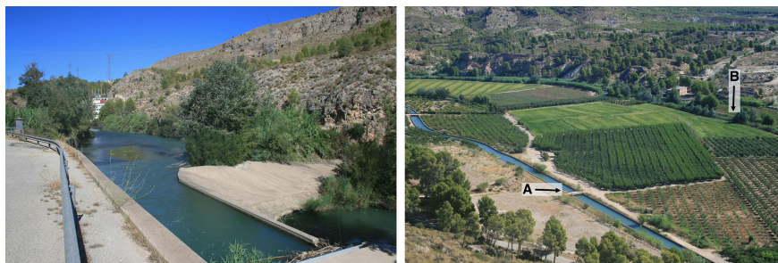
Figura 7. A la izquierda, azud y toma de la acequia de Berberín. A la derecha, paisaje regado en Calasparra, con predominio de arrozal pero con la aparición reciente de frutales de hueso. Entre las acequias de Berberín (A) y Rotas (B)
