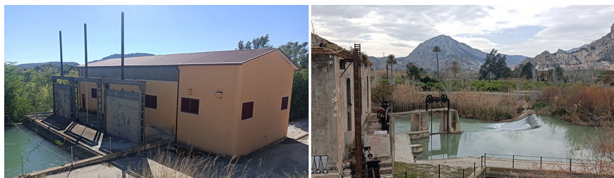
Figura 10. A la izquierda, central hidroeléctrica de Berberín. A la derecha, azud del Golgo, presa que antaño alimentaba a la central hidroeléctrica de Ulea
