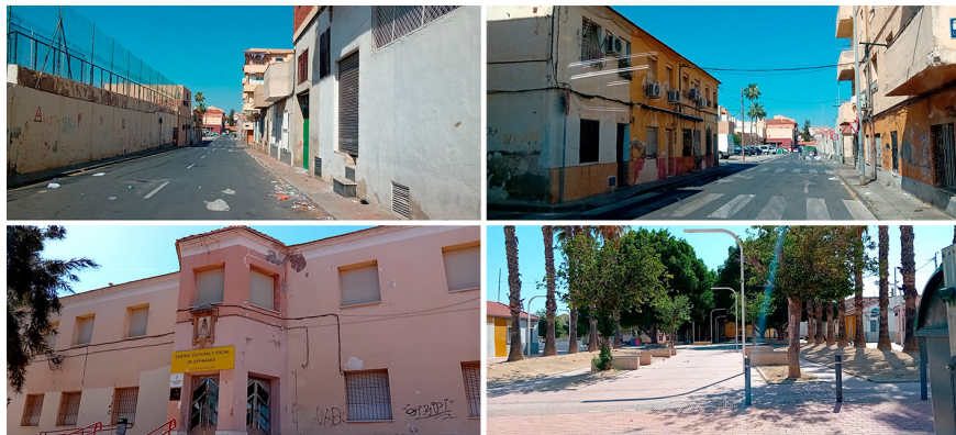
Figura 6. Estado de deterioro de las viviendas y de los equipamientos públicos
