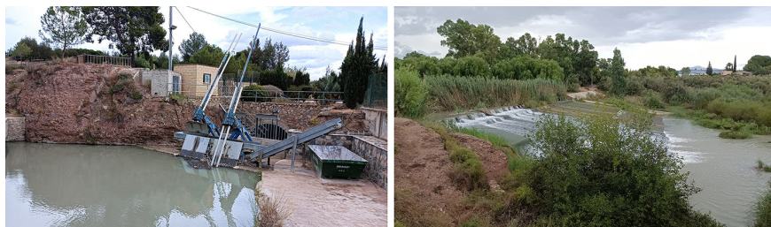
Figura 9. Sistema de La Contraparada. A la izquierda, toma de la acequia de La Alquibla-Barreras. A la derecha, situado más abajo, el Azud
